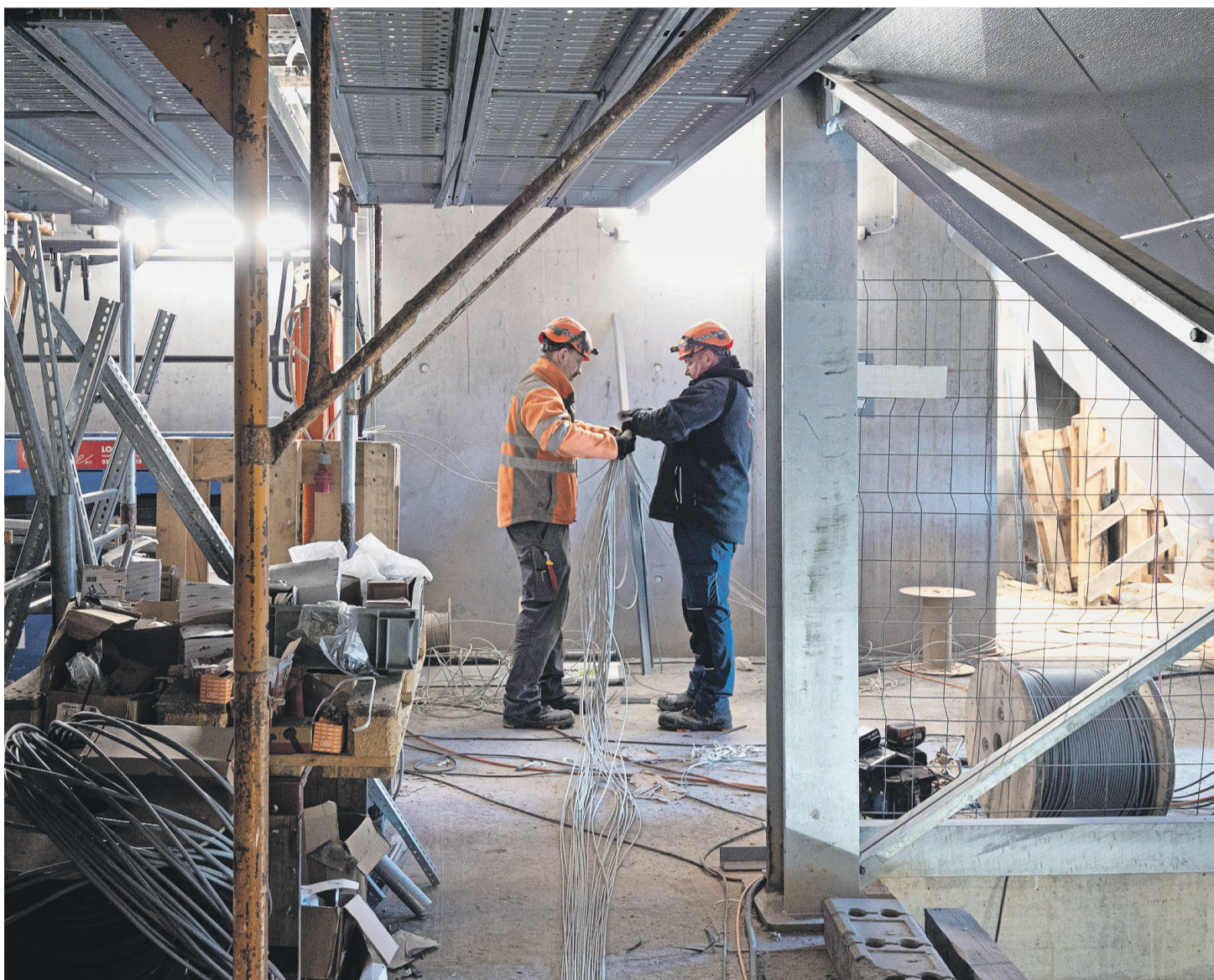
Die Bauarbeiten sind in vollem Gange. Die Inbetriebnahme der Anlage wird in den kommenden Monaten schrittweise erfolgen.
